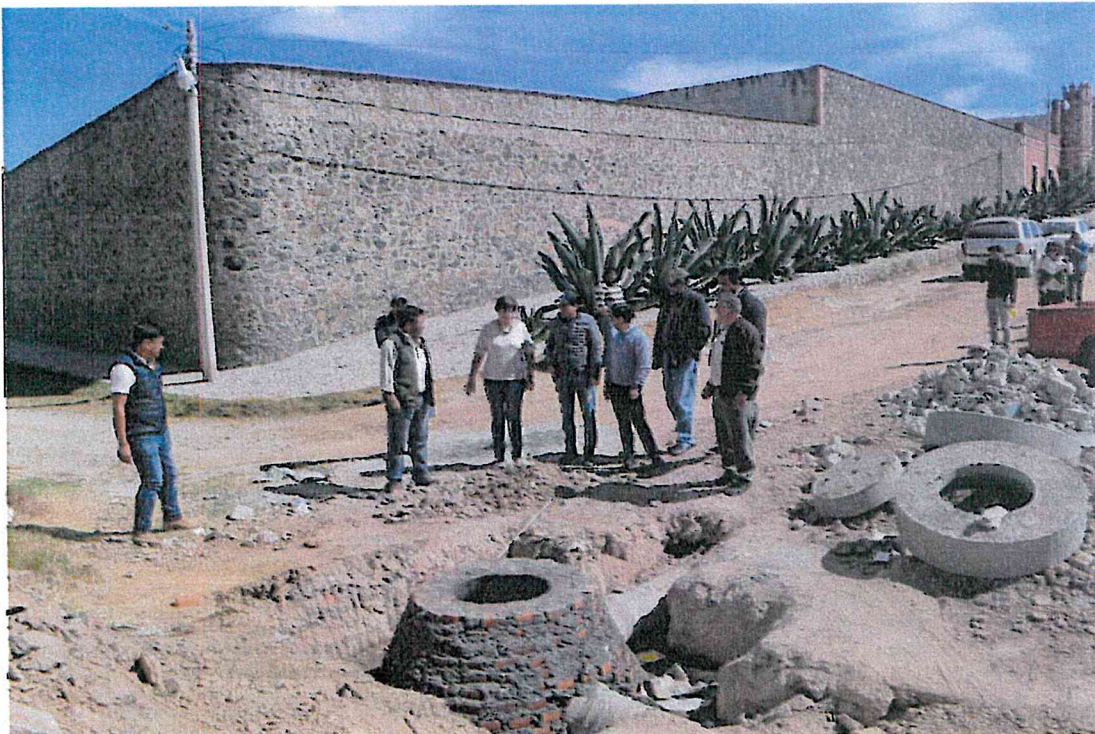
Foto: Instalación de red de drenaje en diversos puntos del Municipio.
