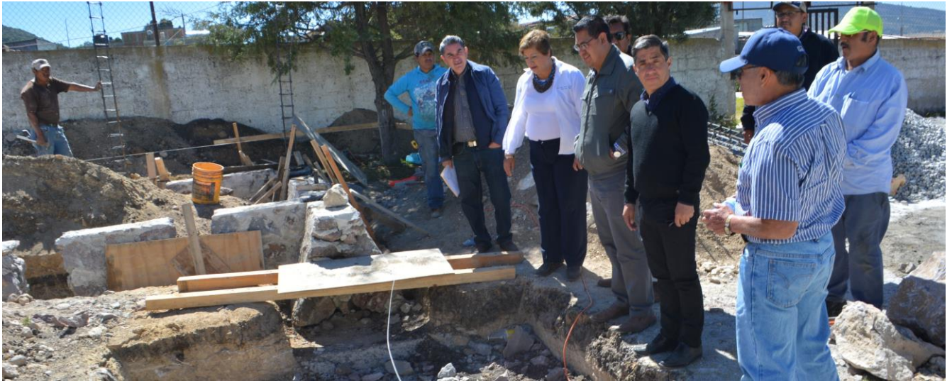
Foto: Supervisión de Obra en Escuela Primaria “Josefa Ortiz de Domínguez” Localidad: Cocinillas.
