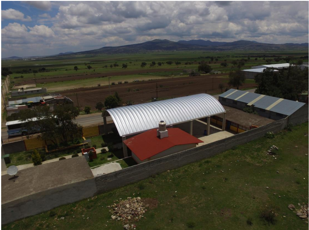
Foto: Techumbre escuela primaria “Belisario Domínguez” localidad: Voladores
