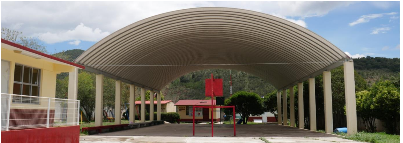
Foto: Techumbre en Escuela Primaria “10 de mayo” Localidad: Alcantarillas.
